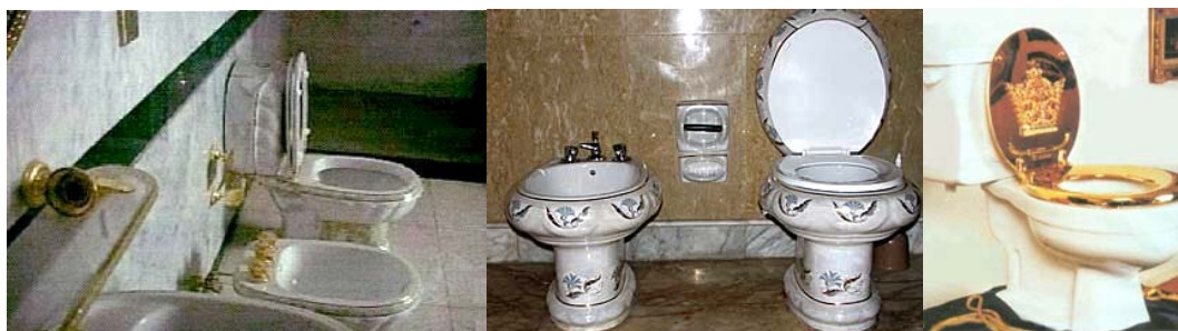
Рис. 4. Сантехническое оборудование во дворцах Саддама Хусейна
