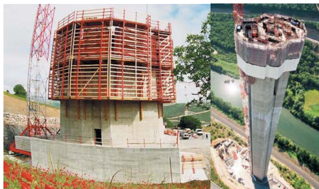
Рис. 37. Опоры подвесного моста Милло на трассе Париж-Барселона
